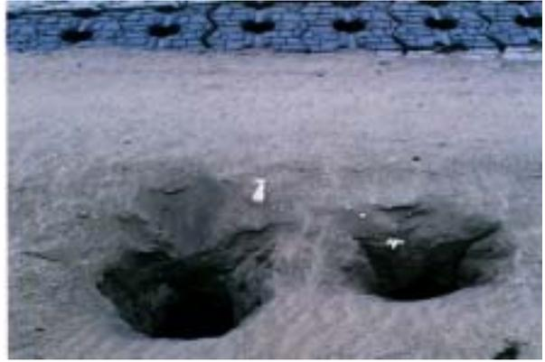
写真4 砂浜表面から判別しやすい砂の吸出し痕跡
