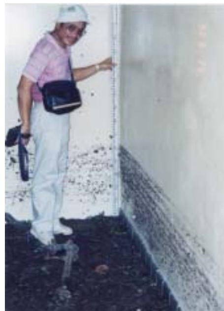
写真3 基準面から約3mの高潮痕跡
